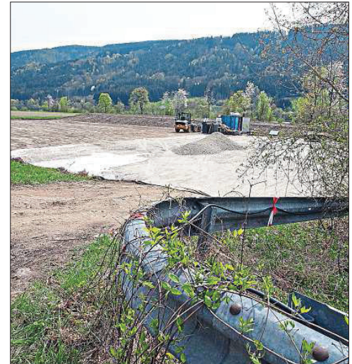
Ein Zwischenlager für aufgebrochenes Straßenmaterial ist in Kohlbachmühle eingerichtet worden.
